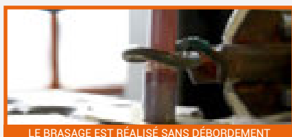
LE BRASAGE EST RÉALISÉ SANS DÉBORDEMENT
